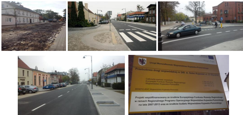
Przebudowa odcinka drogi wojewódzkiej nr 249 – ul.23 stycznia
