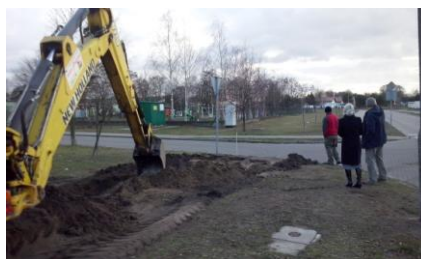
Budowa chodnika i bezpiecznego przejścia na os. Toruńskim
