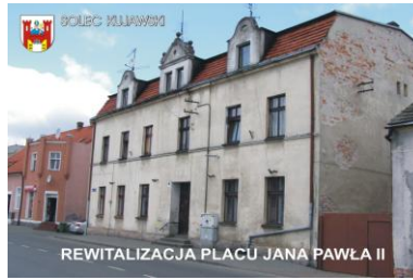
Budynek przy Placu Jana Pawła II
