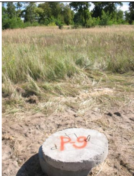
Ryc. 14. Przykładowy wygląd obudowy piezometru po wykonaniu studzienki osłonowej z płytą betonową.
