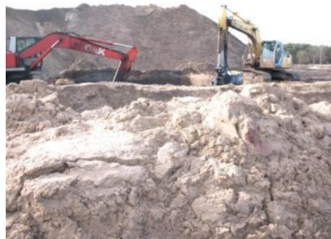
Ryc. 111. Uprany, jasnożółty piasek na ociekaczu (na pierwszym planie) to ewidentny wynik lepszego sprzętu oraz poprawy umiejętności personelu. W tle pryzma buforująca ziemię do procesu prania. Jej lokalizacja w bezpośrednim sąsiedztwie basenu zapewniała sprawny załadunek kolejnych partii gruntu do prania.
