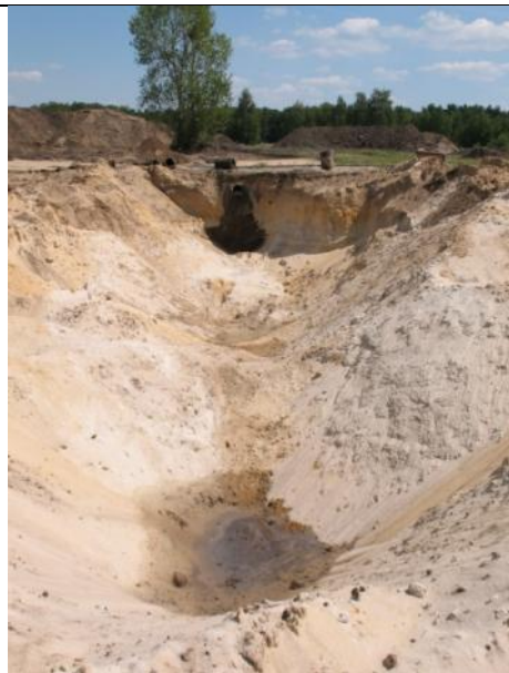
Ryc. 59. Poprzednia struktura w gruncie z większej perspektywy – koparka usunęła selektywnie całą strefę silnie skażoną wyciekami kreozotu z betonowego kanału, który miał za zadanie „coś” odwadniać.
