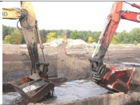
Ryc. 110. Dwie łyżki piorące w akcji w starym zbiorniku do prania gruntu.
