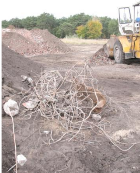
Ryc. 206. W trakcie kruszenia gruzu z nowszych, żelbetonowych fundamentów odzyskiwano do recyklingu część stali zbrojeniowej
