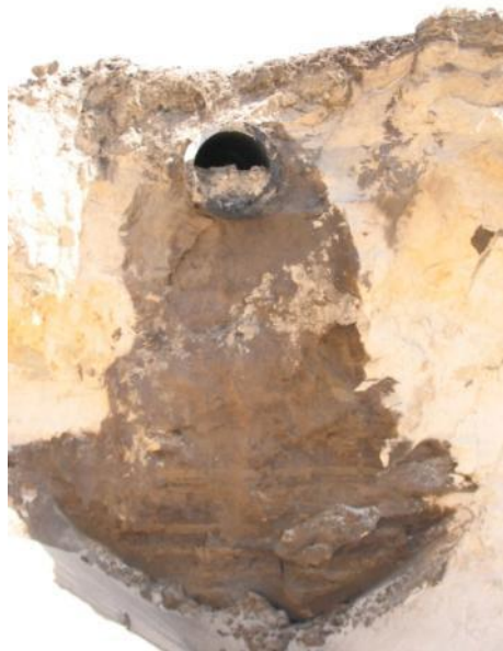
Ryc. 58. Tropienie skażeń w gruncie koparką i ich usuwanie łącznie z infrastrukturą, sprawcą wycieków o charakterystycznym kształcie „dzwonu” – dość zaskakująca struktura w otaczającym ją czystym piasku.
