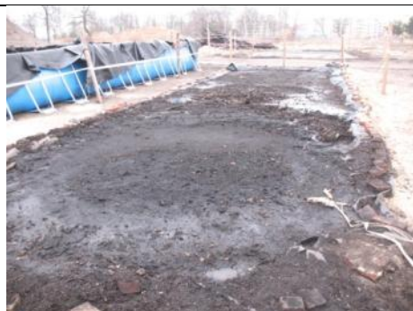
Ryc. 145. Gdy osadnik był napęczniony, konieczne było załadowanie odpadu do zbiorników transportowych.
