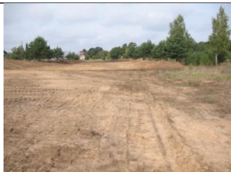
Ryc. 79. Teren pod wykorytowanie obszaru pod przyzmę najpierw wyrównano i wytyczono wymagane spadki, by wewnątrz izolowanej kwatery odcieki kierowały się w wymaganym kierunku.
