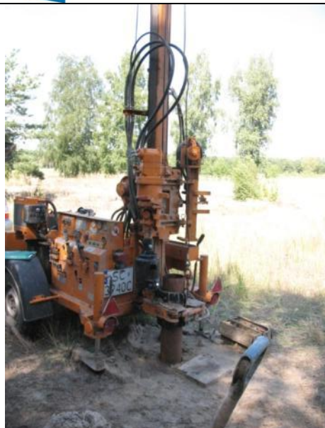
Ryc. 12. Wiercenie otworu pod piezometr P2 na granicy południowej terenu rekultywowanego. Wrzesień 2013.
