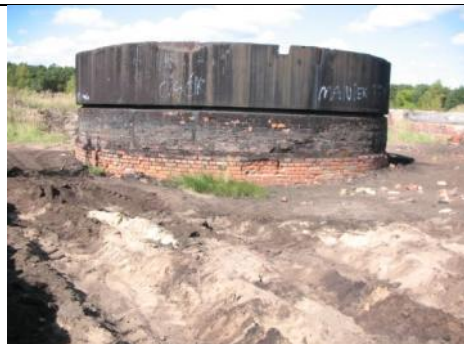
Ryc. 1. Ucięty zbiornik nadpoziomowy zawierający pastę kreozotową wymagał interwencji i usunięcia w pierwszej kolejności, gdyż od lat stanowił otwarte ognisko skażenia gruntu, wody oraz powietrza.
