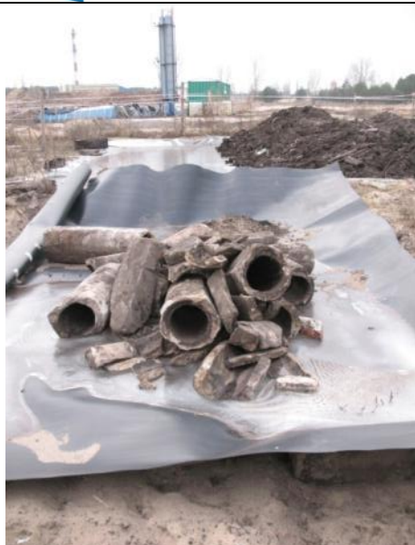
Ryc. 215. Części wykopanego kolektora ściekowego zgromadzono odrębnie ze względu na zawarte w rurach smoły kreozotowe, praktycznie nie nadające się do sanacji w procesach biologicznych.
