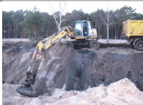
Ryc. 60. Tym „czymś” była prawdopodobnie najstarsza, poniemiecka jeszcze, pomocnicza strefa rozładunku kreozotu z wagonów. Masywne, głębokie skażenie gruntu było przysypane ok. 0,5 metrową warstwą ziemi i z wierzchu praktycznie niewidoczne. Na zdjęciu pace wydobywcze w miejscu tzw. „pola 1” według umowy uzupełniającej z Wykonawcą.
