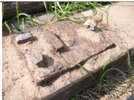
Ryc. 241. Opisany powyżej podkład to świadectwo starej techniki kolejowej – okucia do szyn przybite są trzema specjalnymi, kutymi gwoździami (tzw. szyniakami) o charakterystycznej główce umożliwiającej podważenie i wyciągnięcie przy poprawianiu szyn.
