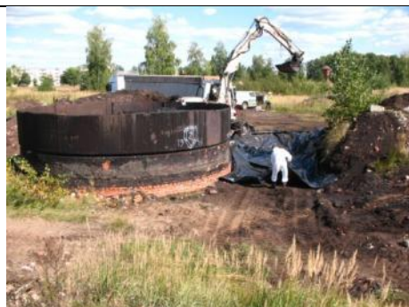
Ryc. 173. Usuwanie resztek kreozotu z uciętego zbiornika – wrzesień 2013. Przy samym zbiorniku ułożono dodatkową grubą folię ochronną, by ewentualne resztki mazi spadające z łyżki koparki załadowującej specjalne naczepy nie zanieczyściły dodatkowo okolicznego gruntu.
