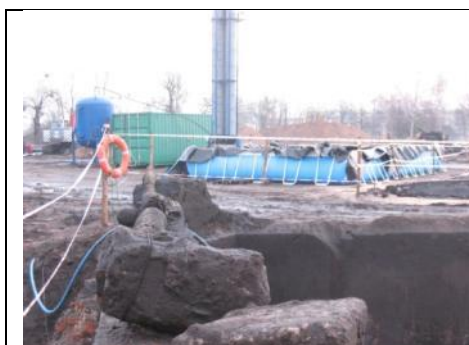
Ryc. 189. Na drugim planie rozstawiany basen do regulacji pH wody oraz wieża strippingowi, kontener z pompami oraz zbiornik z węglem aktywnym (niebieski cylinder).
