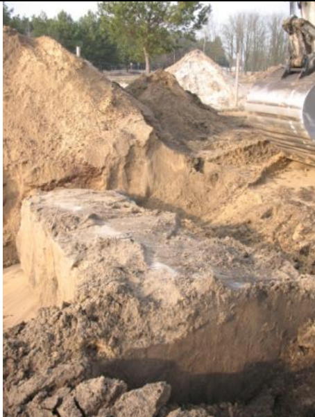
Ryc. 199. Inny lity blok betonowy odkryty w północno-zachodniej części sektora D3 w celu usunięcia wymagał sporo pracy. Ziemia wokół nie była zanieczyszczona.
