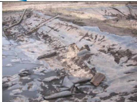
Ryc. 143. Niepotrzebne osadniki, opróżnione ze szlamów, są kolejno likwidowane – geomembrana stanowi już tylko odpad, kontroluje się też stan podłoża przed zasypaniem zagłębień.
