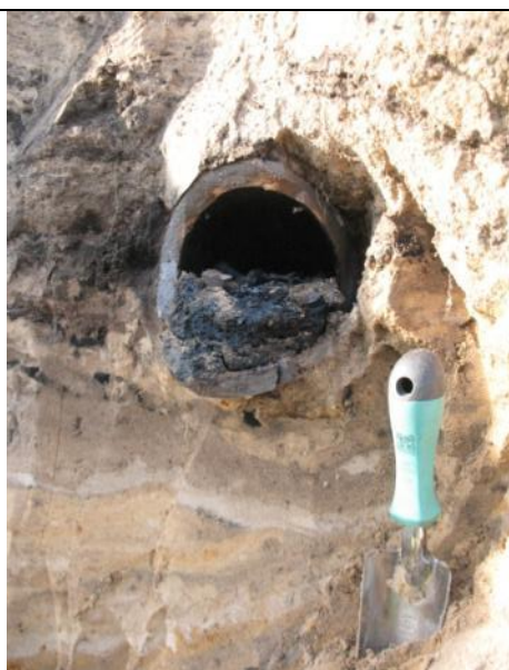
Ryc. 216. Inne, kamionkowe rury kanalizacyjne, także do połowy przekroju wypełnione gęstą kreozotową mazią. Tu: fragment jednego ze starych kolektorów ściekowych z dodatkowego miejsca rozładunku kreozotu użytkowanego w czasach, których nie pamiętają już najstarsi świadkowie.
