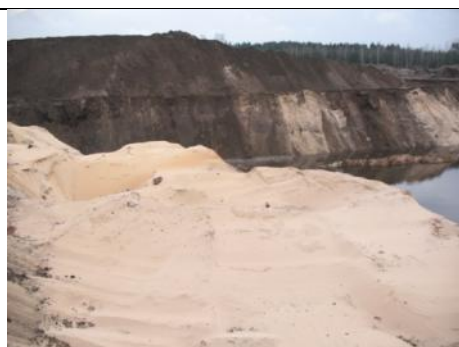
Ryc. 50. Intensywne i głębokie prace wydobywcze na granicy sektorów D3 i E4 wyraźnie obnażyły różnice pomiędzy rodzimym gruntem skażonym i tym bez zanieczyszczeń.
