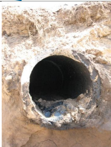
Ryc. 213. Betonowa rura ściekowa odstonięta w oryginalnym położeniu. Mogła służyć jako odwodnienie, jednak w 1/3 wypełniona jest gęstą mazią kreozotową.
