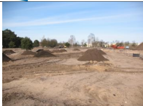
Ryc. 78. W obszarze od strony ul. Parkowej na przygotowanym podłożu (miejscami wymiana gruntu, usunięcie masywnych struktur betonowych) nawieziono i rozprowadzono warstwę glebową zdjętą stąd przed głębokimi pracami ziemnymi i przesianą na sitach w celu odseparowania większych odpadów, w tym gruzu.
