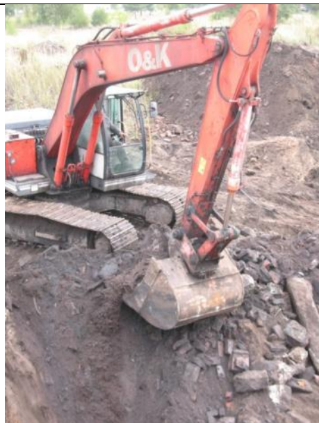
Ryc. 48. W centralnej części dawnej nasycalni usuwaniu fundamentów i infrastruktury towarzyszyło wydobywanie najczęściej silnie skażonego gruntu. Ten zatem, po selekcji na przesiewaczu, kierowany był do płukania.
