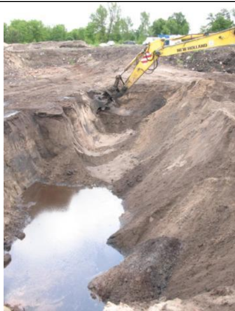
Ryc. 49. Po usunięciu fundamentów kontynuowano prace wydobywcze – pod dawną halą nasycen grunt był skażony w całym profilu aż do wód gruntowych, tj. ok. 4,5 m
