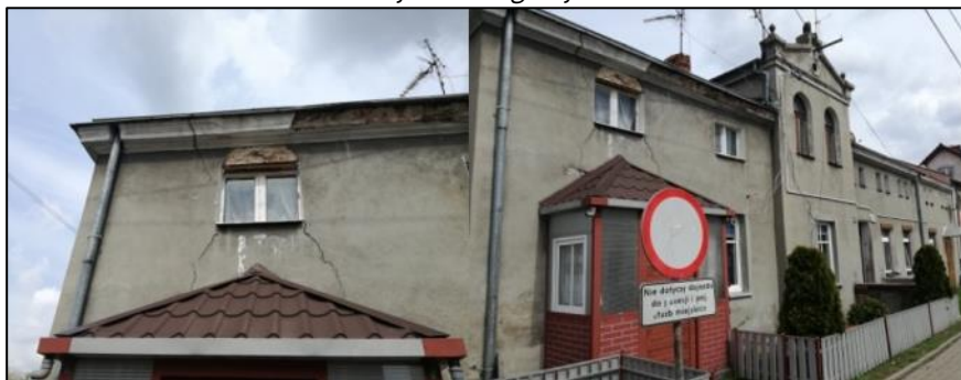
Ilustracja 12. Obszar rewitalizacji, budynek przy ul. Bydgoskiej 14, działka nr 463 - zły stan stwierdzono w 7 na 8 kryteriów ogólnych
