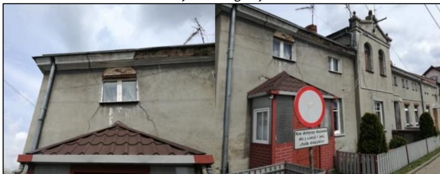
Ilustracja 12. Obszar rewitalizacji, budynek przy ul. Bydgoskiej 14, działka nr 463 - zły stan stwierdzono w 7 na 8 kryteriów ogólnych
