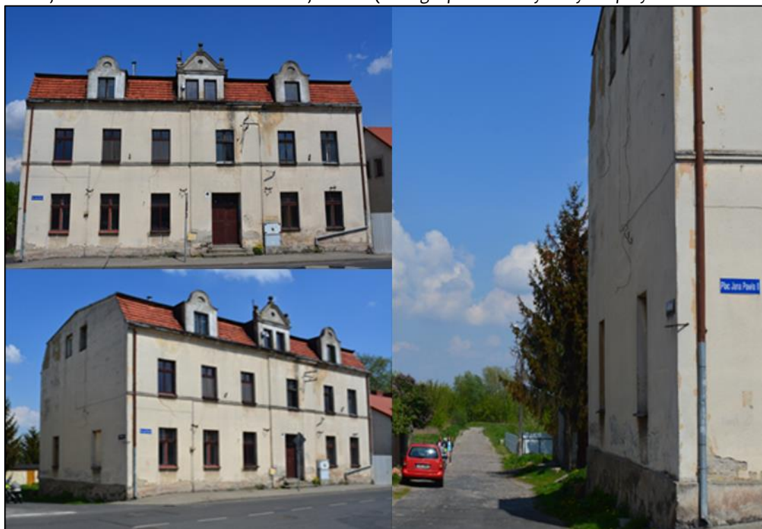
Ilustracja 18. Plac Jana Pawła II w Solcu Kujawskim (niezagospodarowany budynek przy drodze do Wisły)
