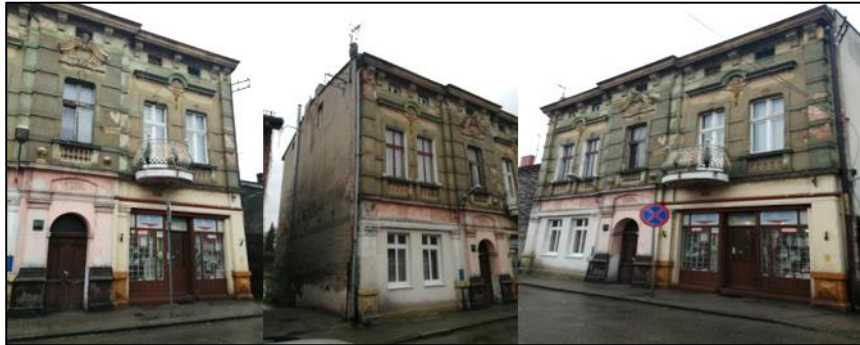
Ilustracja 17. Obszar rewitalizacji, budynek przy ul. Toruńskiej 2, działka nr 702 - zły stan w 7 na 8 kryteriach głównych
