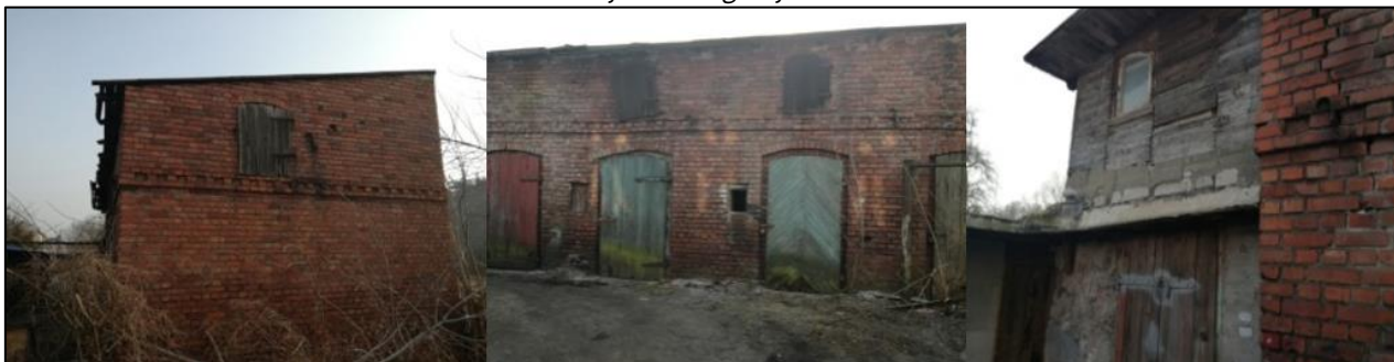
Ilustracja 17. Obszar rewitalizacji, budynek przy ul. Toruńskiej 16, działka nr 696 - zły stan stwierdzono w 6 na 8 kryteriów ogólnych
