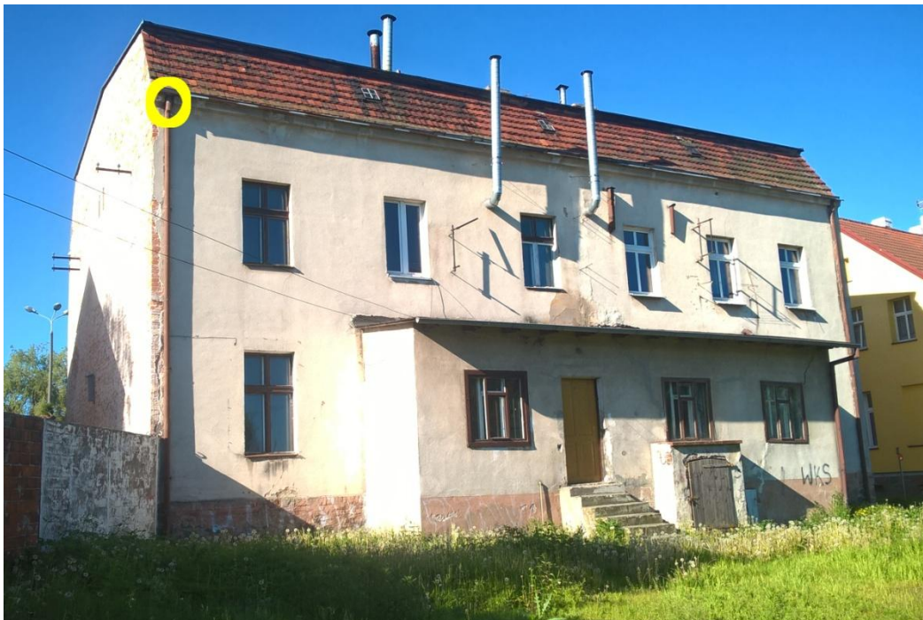
Fot. 2. Elewacja północna. Kolorem żółtym zaznaczono miejsce wlotu do siedliska jerzyków, które
