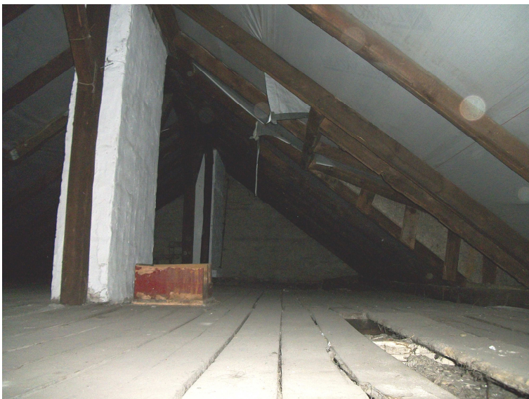
Fot. 2. Ogólny widok więźby dachowej na strychu – strona prawa od schodów
