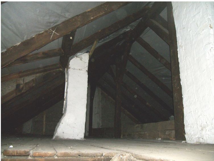
Fot. 1. Ogólny widok więźby dachowej na strychu – strona lewa od schodów
