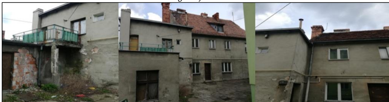
Ilustracja 10. Obszar rewitalizacji, budynek przy ul. Bydgoskiej 2, działka nr 484/2 - zły stan w 7 na 8 kryteriach głównych
