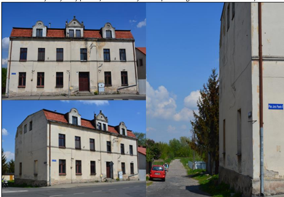
Ilustracja 21. Budynek przy Placu Jana Pawła II 4 (niezagospodarowany budynek w centrum miasta) – niewykorzystany potencjał do oddziaływania społecznego na obszar rewitalizacji
