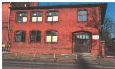
Segment A budynku przy ul. Tadeusza Kościuszki 12 (powstał żłobek)
