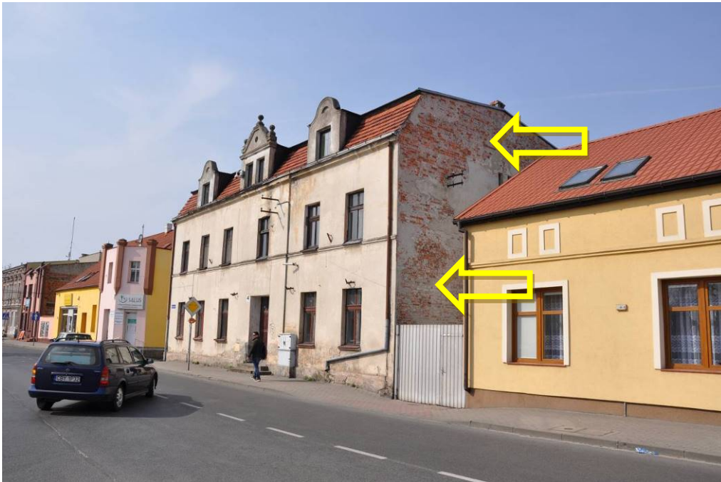
Zdjęcie nr 23 – Popękany i odspojony tynk zewnętrzny na elewacji od strony wsch.
