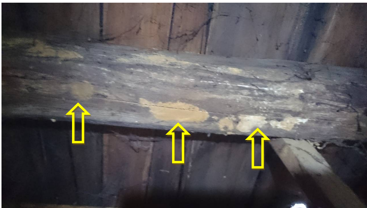
Zdjęcie nr 19 – Liczne ogniska grzybów i pleśni na krokwi dachowej
