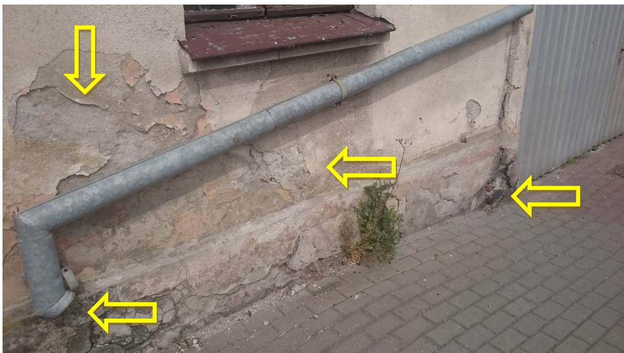
Zdjęcie nr 12 – Pęknięcia i odspojenia tynków oraz nieprawidłowe odprowadzenie wody z dachu przy narożniku pld.-wsch. od strony ulicy
