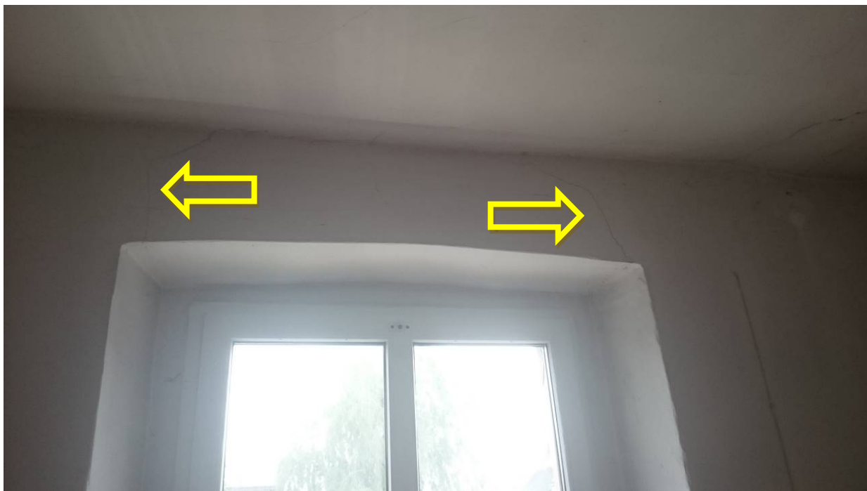
Zdjęcie nr 08 – Pęknięcie ściany i nadproża pomiędzy parterem a piętrem w narożniku płd.-zach. od strony budynku.
