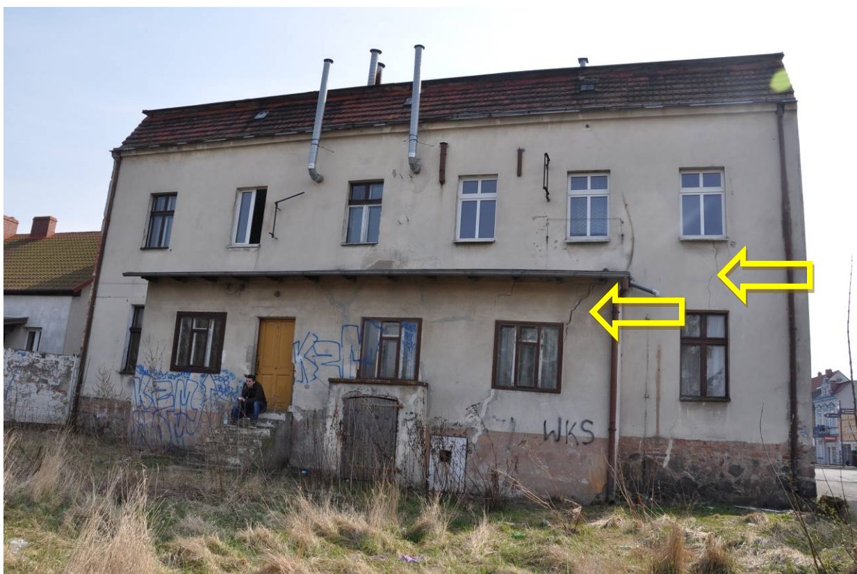
Zdjęcie nr 22 – Pęknięcia elewacji północnej oraz przybudówki
