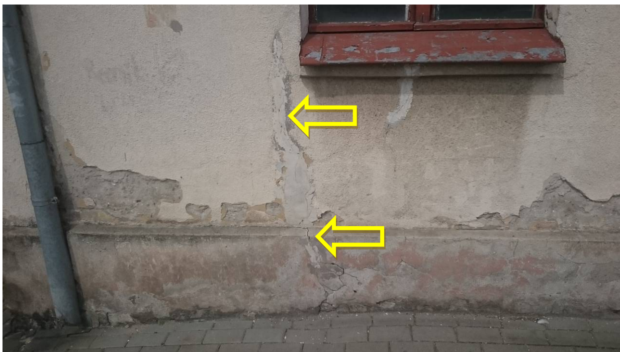
Zdjęcie nr 05 – Pęknięcie ściany w narożniku pld.-zach. od strony ulicy.
