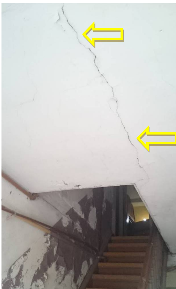
Zdjęcie nr 16 – Pęknięcie stropu na parterze przy schodach wewnętrznych
