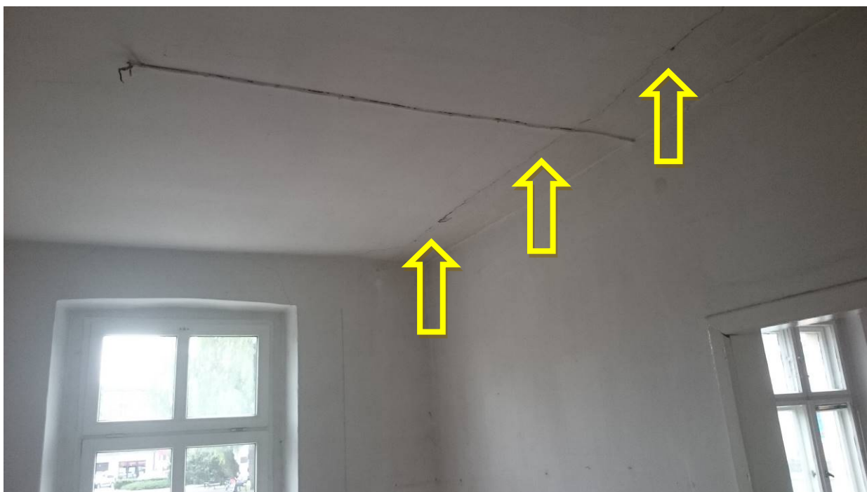
Zdjęcie nr 15 – Pęknięcie stropu na parterze
