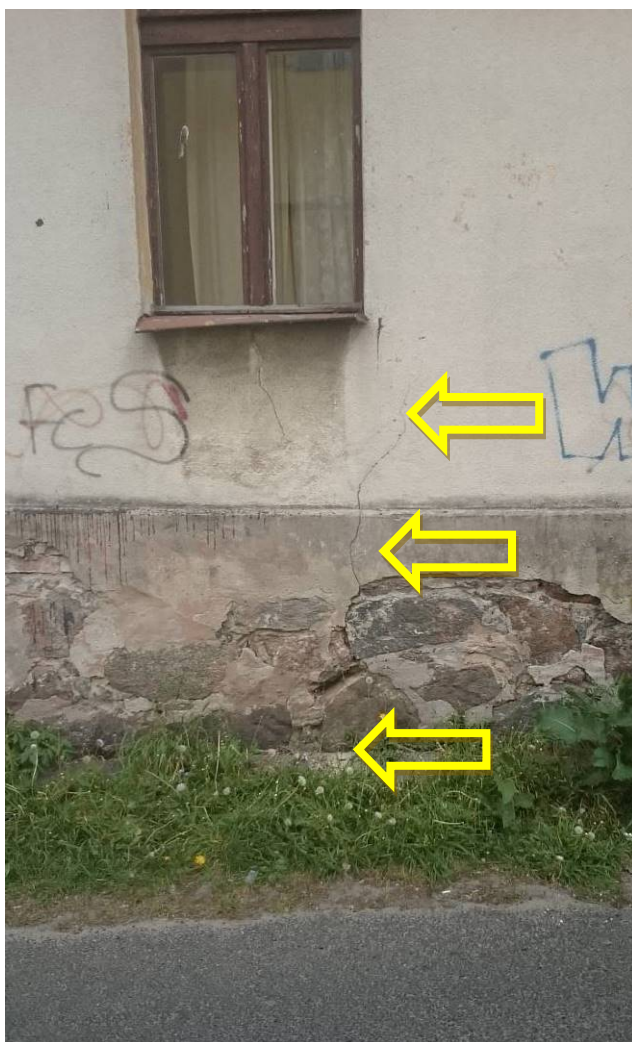
Zdjęcie nr 03 – Pęknięcie ściany fundam. oraz nadziemna od strony zach.
