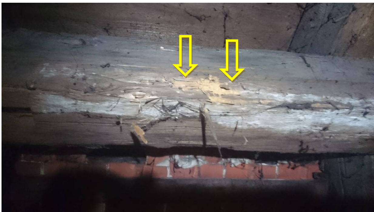
Zdjęcie nr 18 – Korozja biologiczna płatwi (owady), widoczna mączka drzewna
