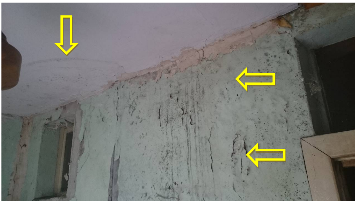
Zdjęcie nr 13 – Zacieki, pęknięcia i korozja biologiczna tynków wewnętrznych na styku budynku głównego i przybudówki
