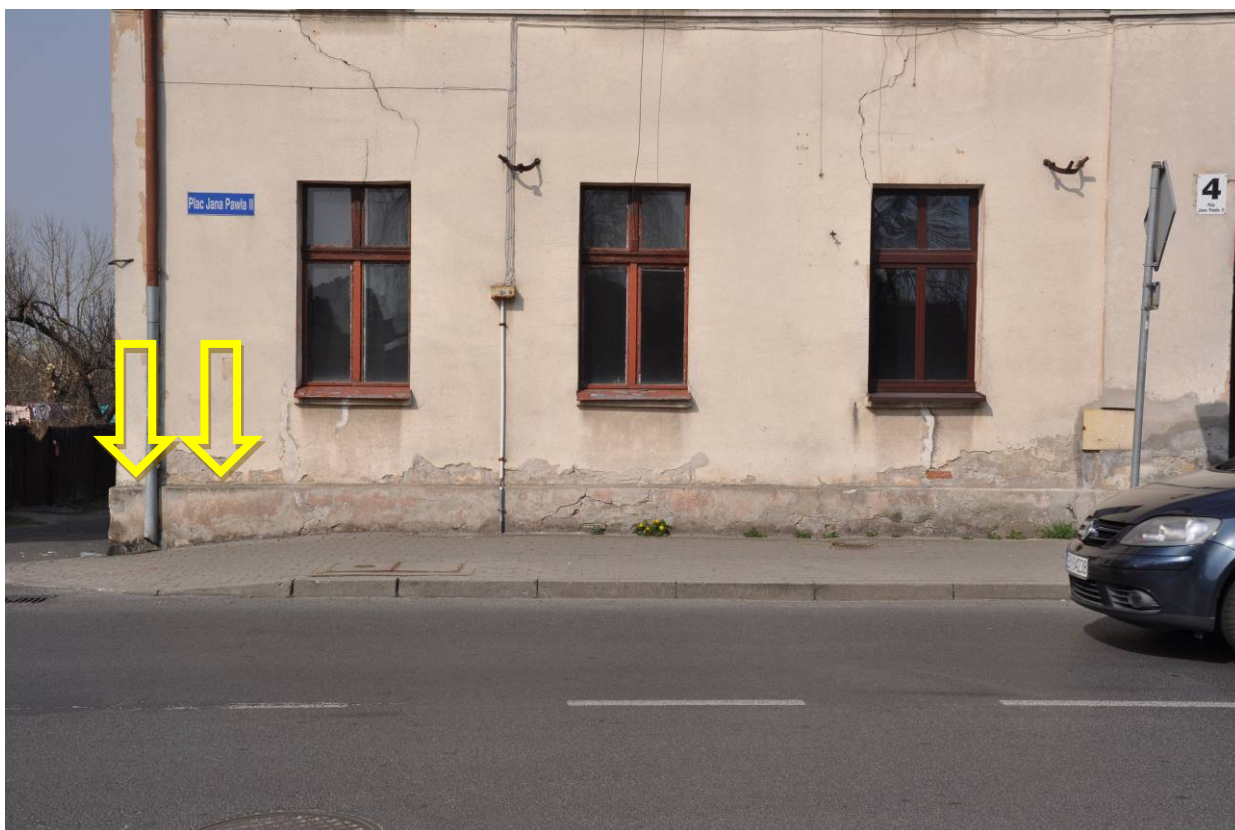
Zdjęcie nr 11 – Obniżenie cokołu spowodowane nadmiernym osiadaniem części zach. budynku
