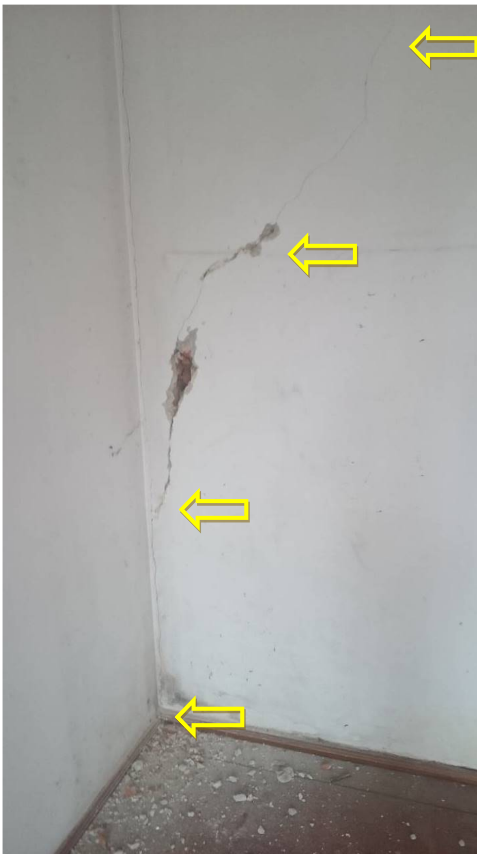
Zdjęcie nr 10 – Pęknięcie ściany wewnętrznej przy ścianie nośnej od strony zachodniej – widok z pomieszczenia od strony południowej
