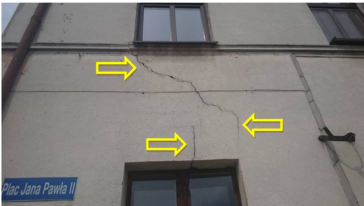
Zdjęcie nr 07 – Pęknięcie ściany i nadproża pomiędzy parterem a piętrem w narożniku płd.-zach. od strony ulicy.
