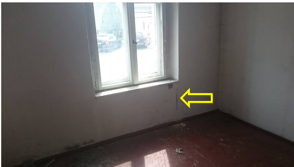
Zdjęcie nr 06 – Pęknięcie ściany w narożniku pld.-zach. od strony budynku.
