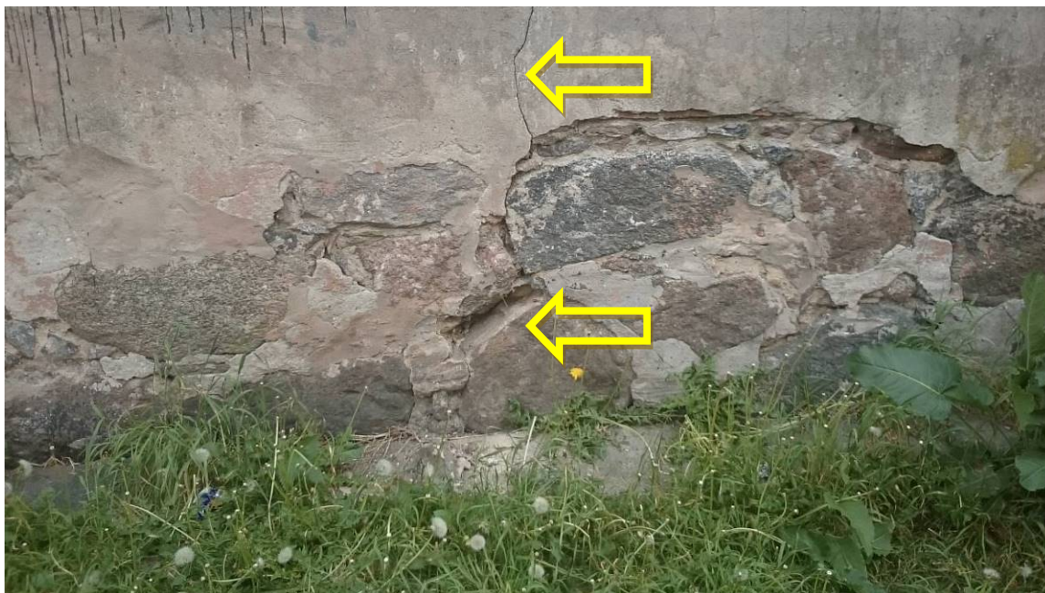
Zdjęcie nr 04 – Pęknięcie ściany fundamentowej oraz spoin od strony zach.
