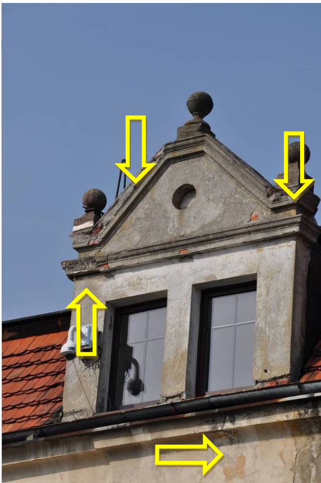
Zdjęcie nr 24 – Pęknięcia, odspojenia i łuszczenie się cegieł oraz tynków na attyce, zacieki i przebarwienia na ścianie spowodowane złym stanem technicznym rynien i obróbek
