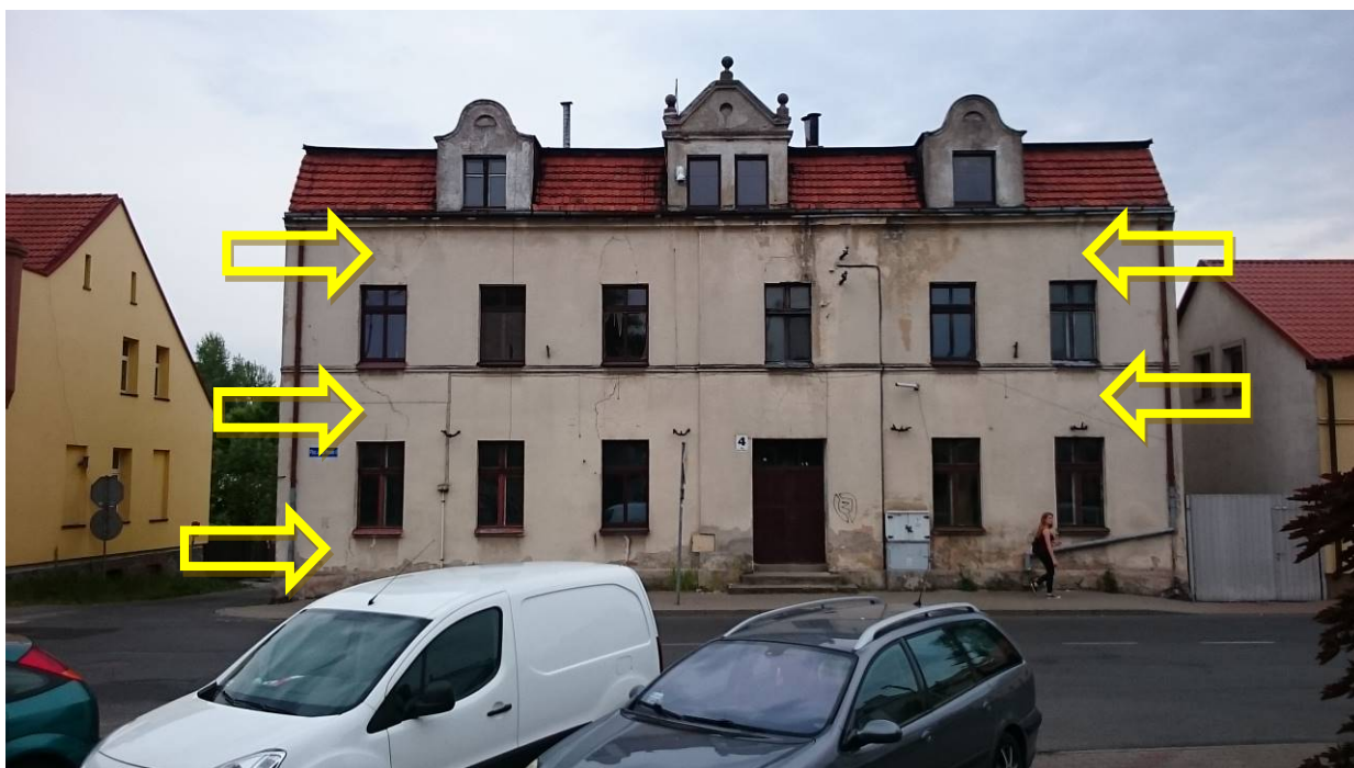
Zdjęcie nr 21 – Pęknięcia elewacji południowej
