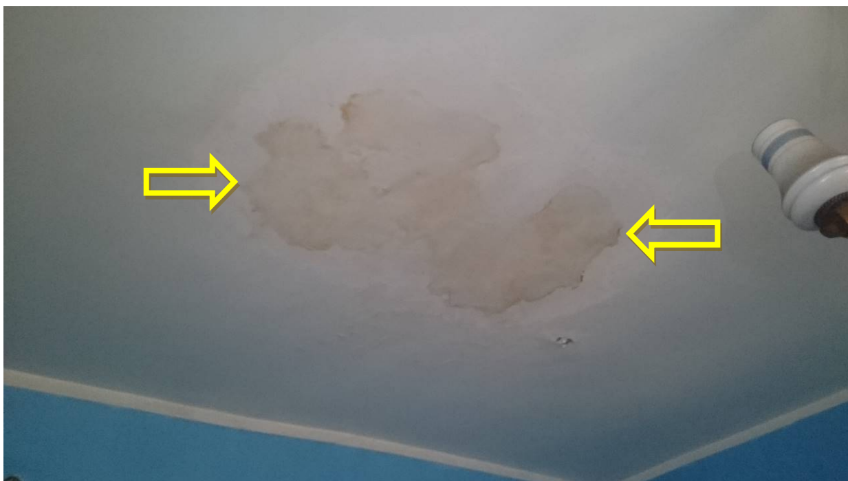
Zdjęcie nr 14 – Zacieki i przebarwienia na stropie parteru spowodowane nieszczelnym pokryciem dachu
