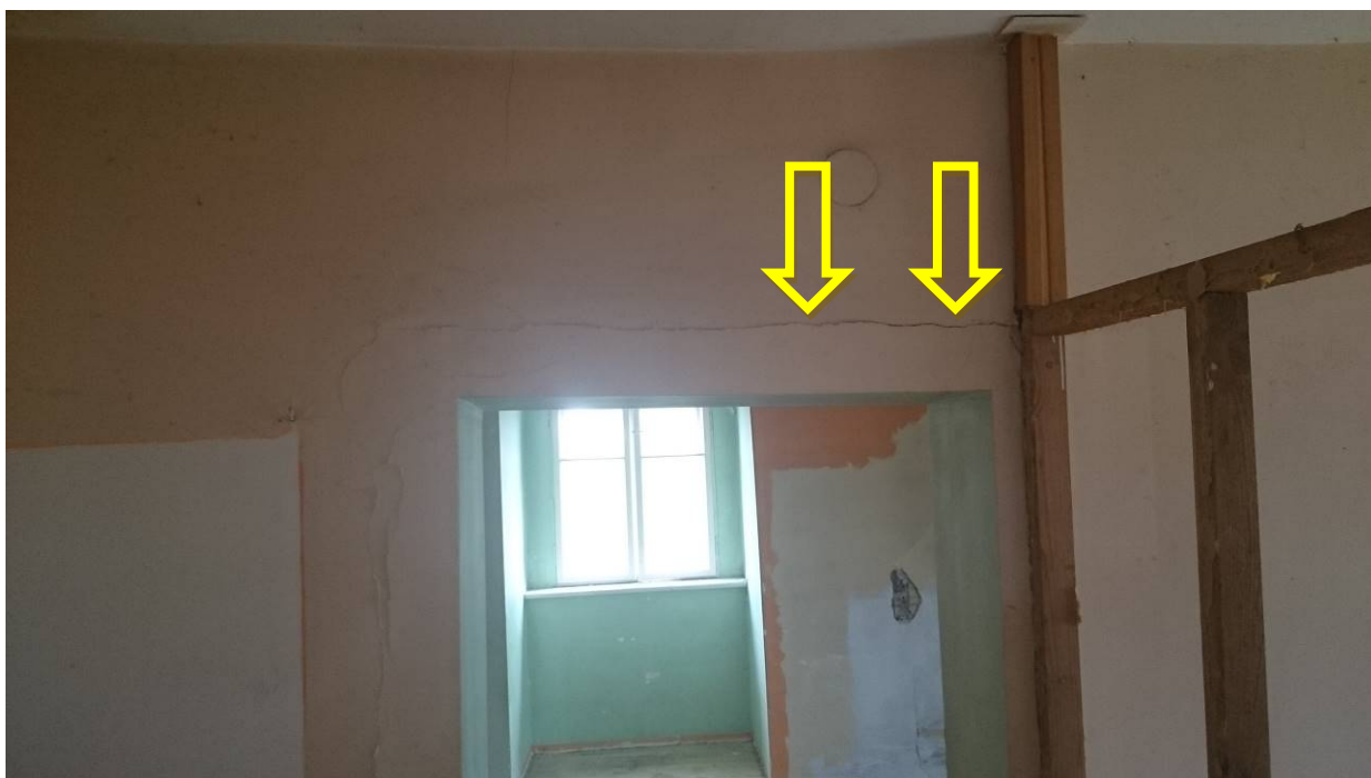
Zdjęcie nr 17 – Pęknięty i pochylony otwór w ścianie spowodowany nadmiernym osiadaniem budynku od strony zach.
