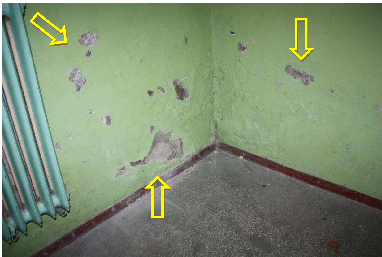
Zdjęcie nr 11 – Pęknięcia, odspojenia i purchle na ścianie w piwnicy
