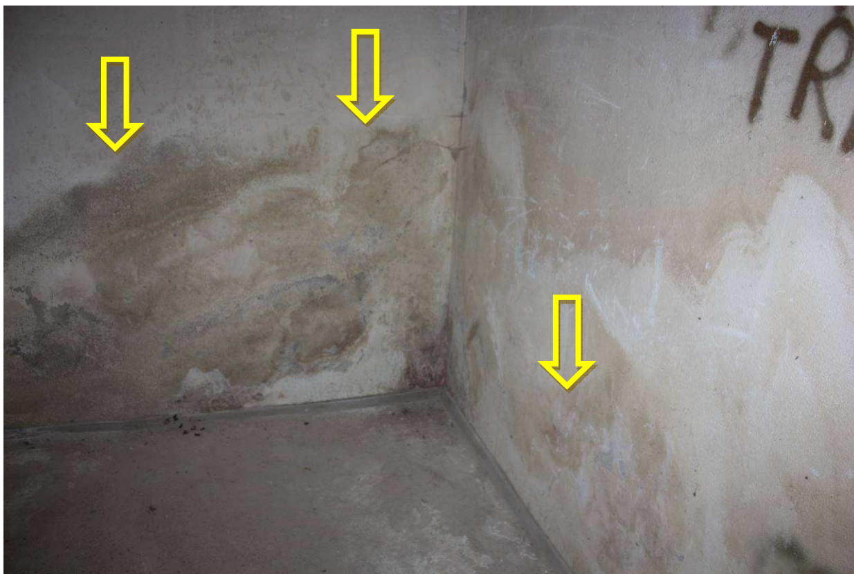
Zdjęcie nr 10 – Zawilgocenie i przebarwienia tynków na ścianach w piwnicy
