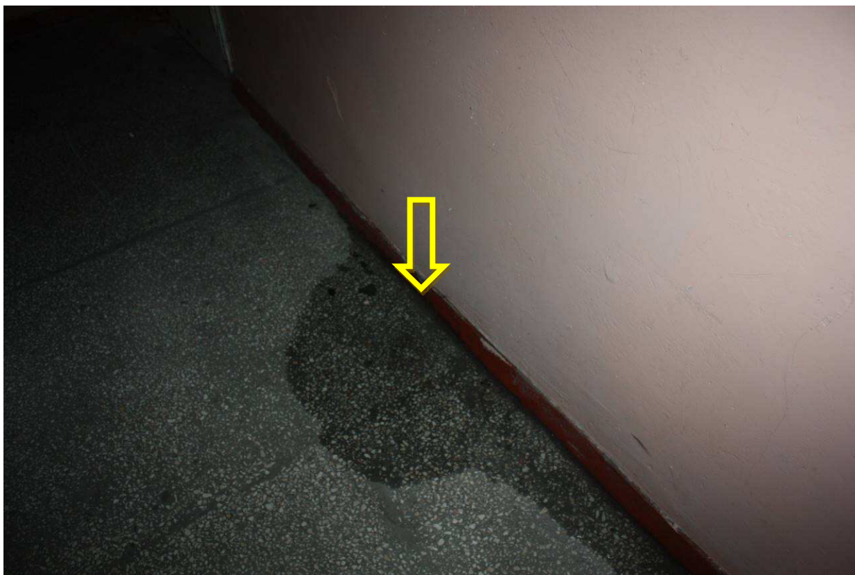
Zdjęcie nr 12 – Zawilgocenie posadzki w piwnicy spowodowane nieuszczelną izolacją wodną
