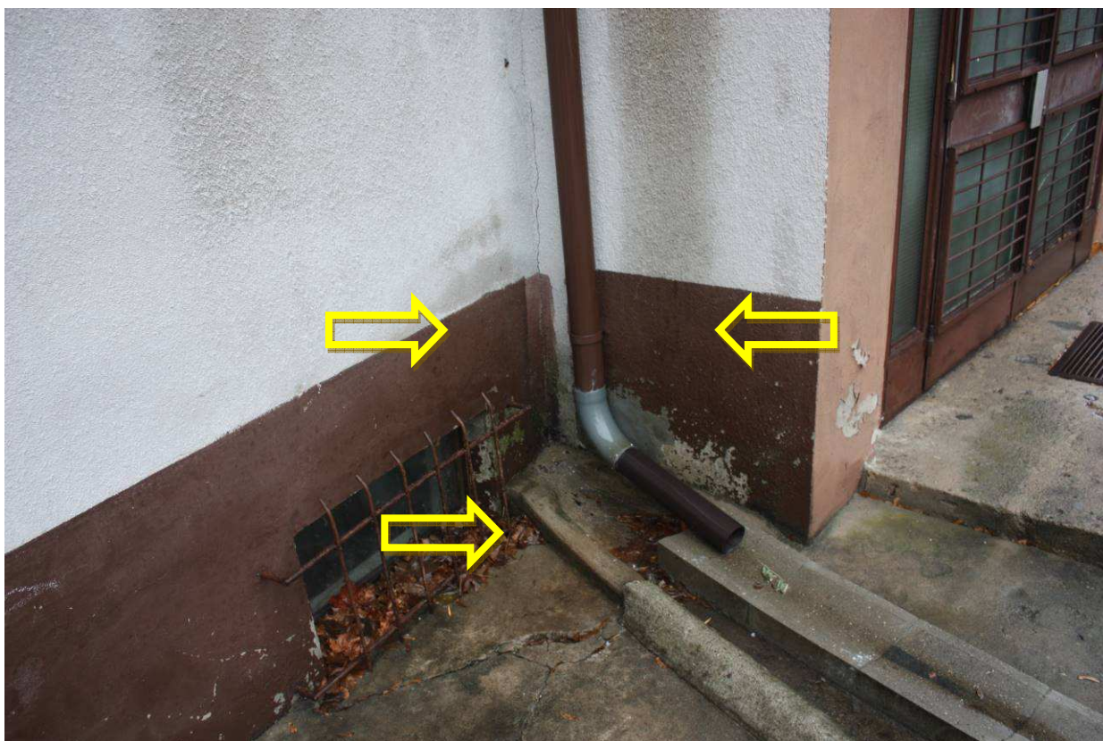
Zdjęcie nr 07 – Zawilgocenie ściany zewnętrznej przy rynnie spustowej
