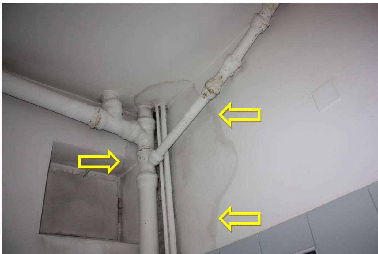
Zdjęcie nr 13 – Zawilgocenia i przebarwienia na stropie i ścianach spowodowane nieszczelną instalacją kanalizacyjną
