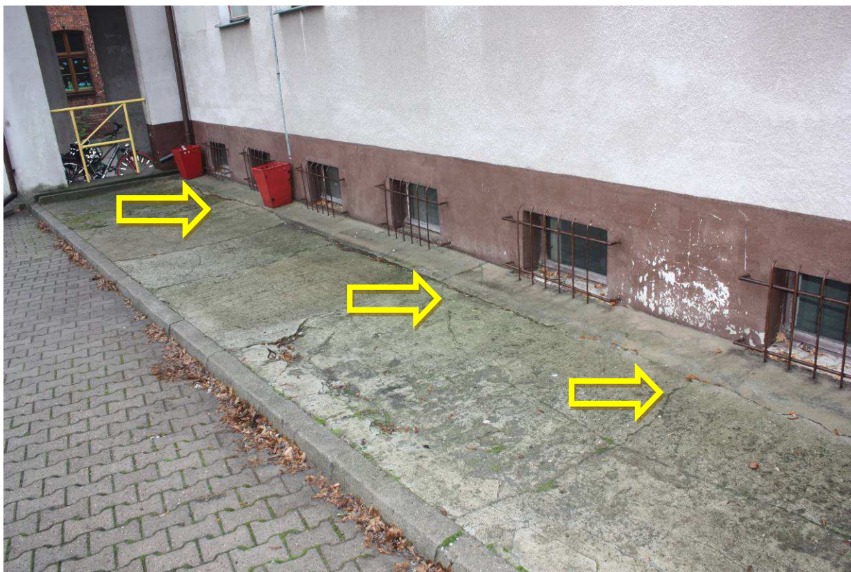
Zdjęcie nr 08 – Popękana opaska betonowa
