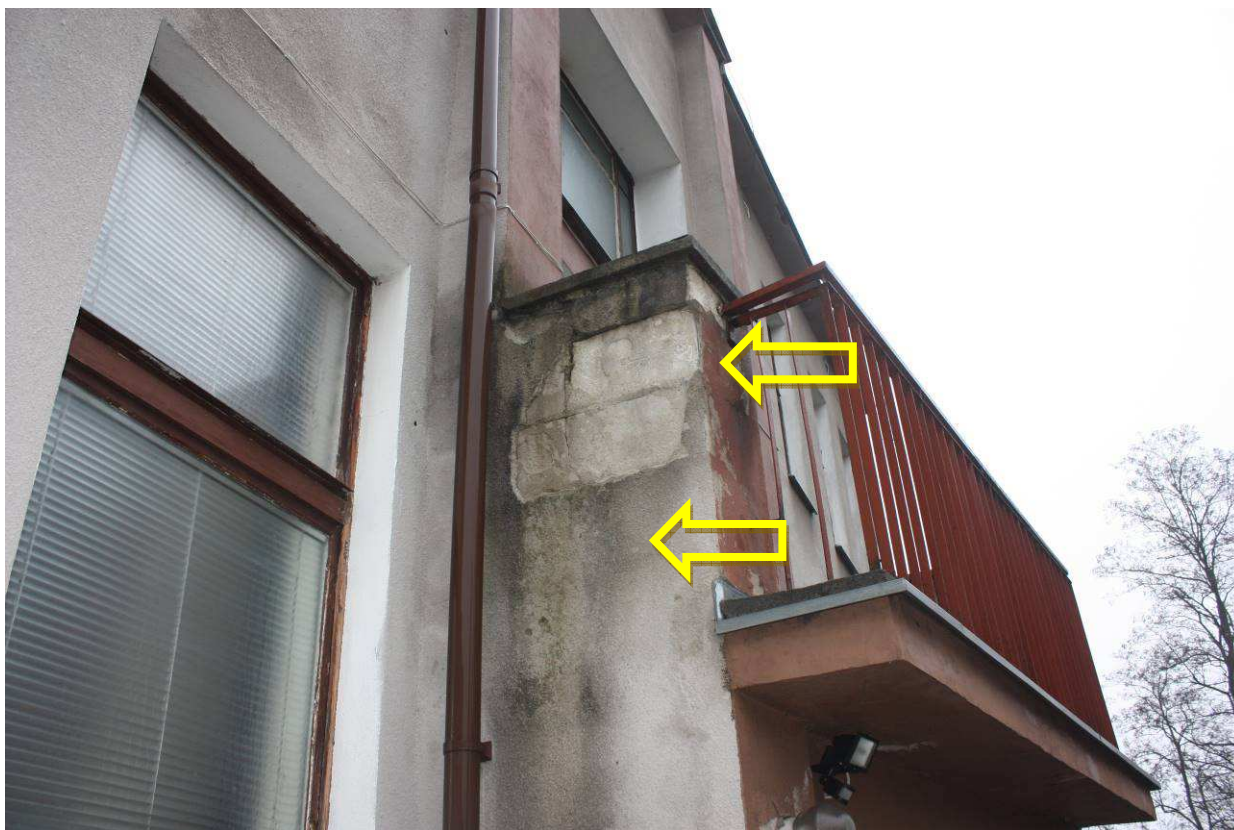
Zdjęcie nr 06 – Zawilgocenie i pęknięcia ścian na tarasie nad wejściem głównym
