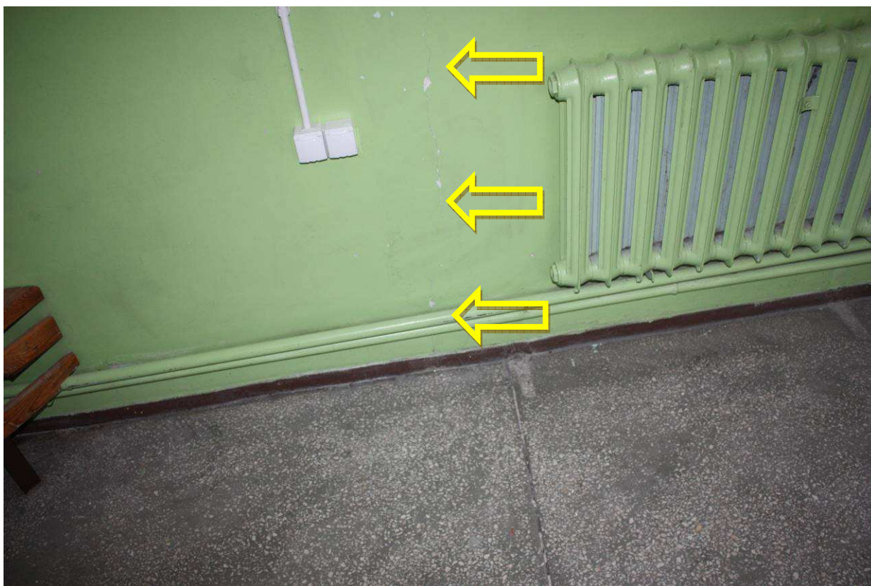
Zdjęcie nr 05 – Pęknięcia i rysy na styku budynku i łącznika od strony wewnętrznej
