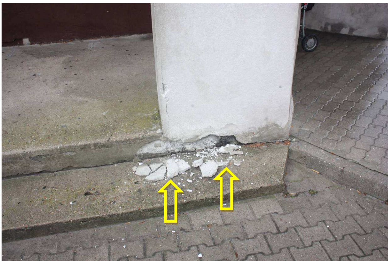
Zdjęcie nr 09 – Pęknięcia i odspojenia tynków zewnętrznych w strefie przygruntowej
