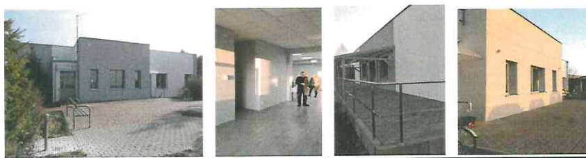
Wyremontowana Świetlica „Jagódka”
