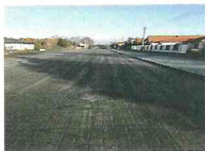
Zmodernizowana ul. Kościelna
