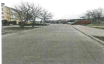
Nowa droga na Osiedlu Toruńskim
