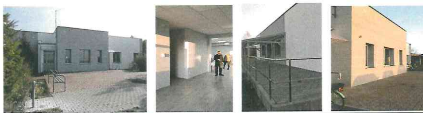
Wyremontowana Świetlica „Jagódka”
