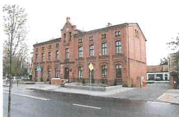
Nowa stolarka okienna w budynku „A”
