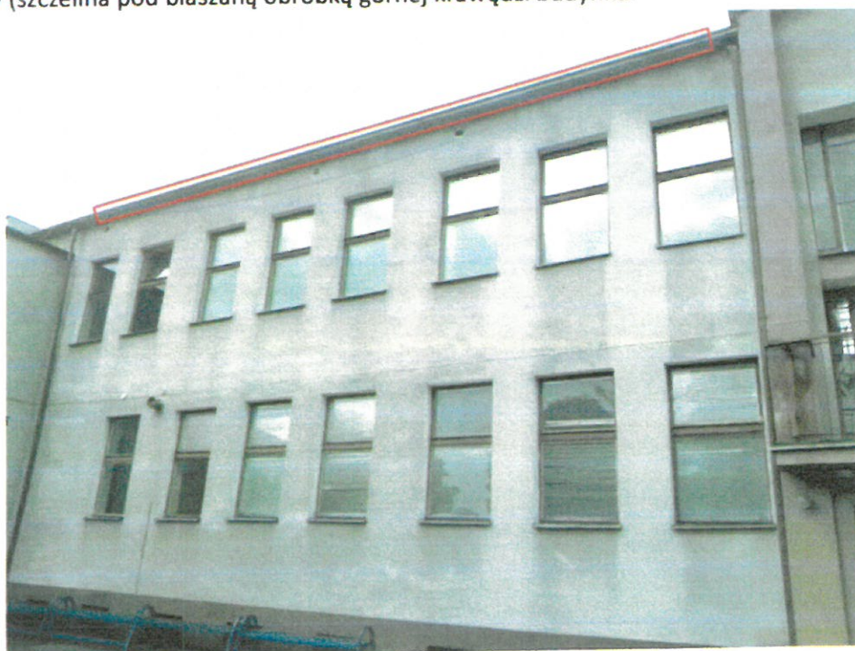
Fot. 1. Lokalizacja miejsca wylotu nietoperzy. Kolorem czerwonym zakreślono miejsce wylotu nietoperzy (szczelina pod blaszaną obróbką górnej krawędzi budynku).
