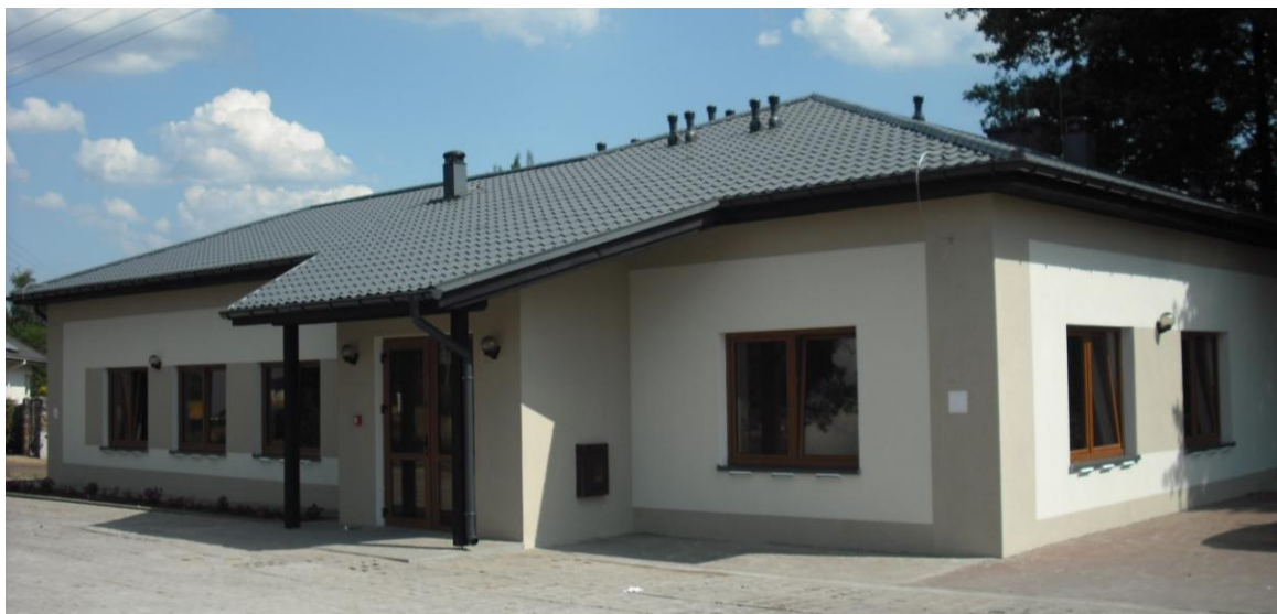
Fot. 1 Elewacja frontowa świetlicy we wsi Makowiska
