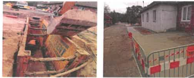
Budowa sieci kanalizacji sanitarnej ul. Robotnicza
