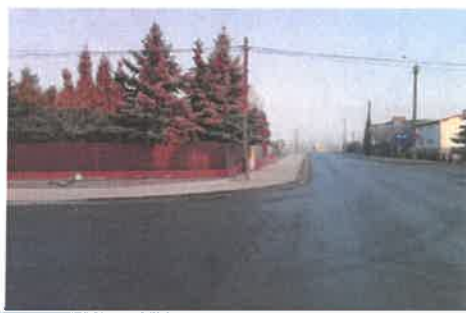
Budowa ścieżki rowerowej wzdłuż ul. ks. Piotra Skargi
