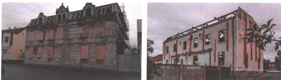
Budynek przy Placu Jana Pawła II 4 w trakcie remontu
