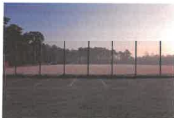
Przebudowa boiska treningowego
