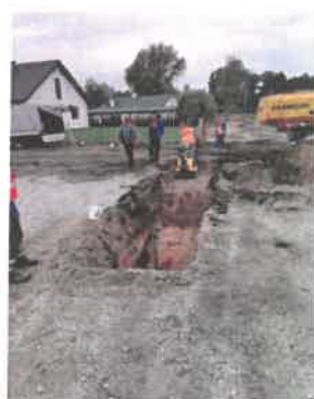
Skanalizowanie rowu melioracyjnego w ul. Szarych Szeregów
