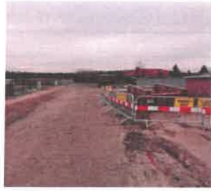
Budowa sieci wod – Kan. w ul. Sowiej
