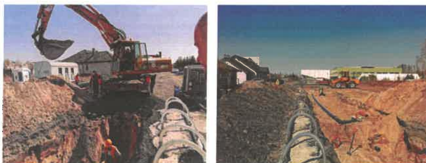
Budowa sieci wod.- kan. w ul. Z. Gierlińskiego
