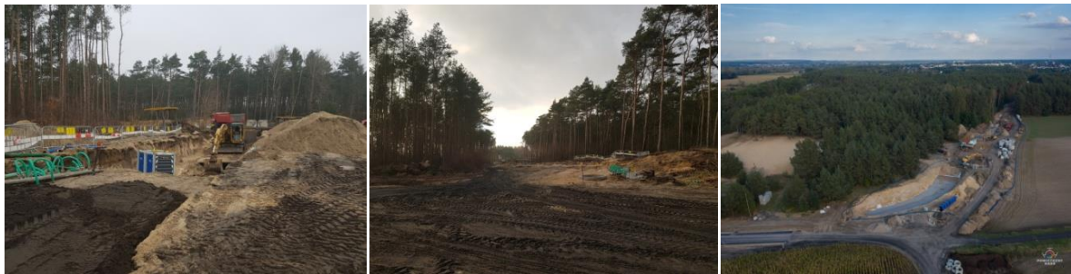
Budowa kanalizacji deszczowej i zbiornika retencyjnego
