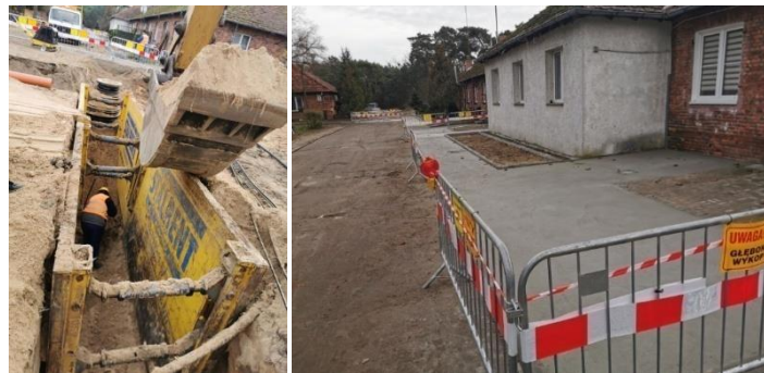
Przebudowa sieci kanalizacyjnej w ul. Robotniczej
