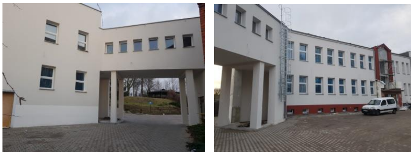
Rewitalizacja budynku przy ul. Kościuszki 12 (segment C)
