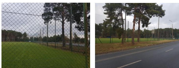
Przebudowa boiska treningowego
