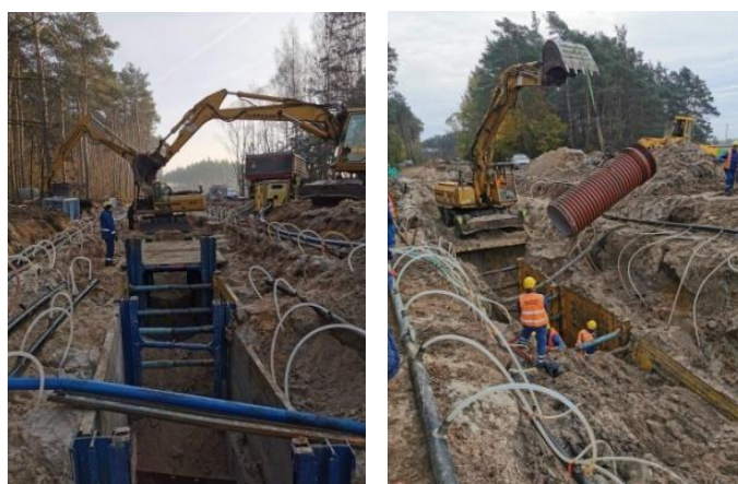
Budowa sieci kanalizacji deszczowej w ul. Targowej
