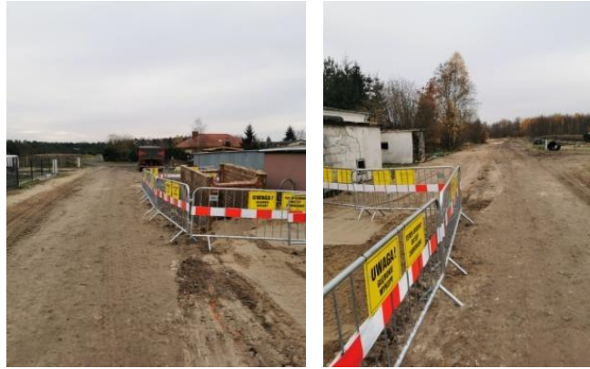
Budowa sieci wod – kan w ul. Sowiej
