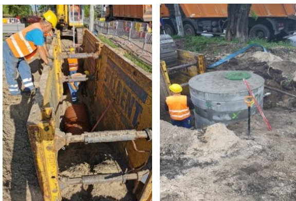
Budowa kanalizacji deszczowej w ul. Długiej
