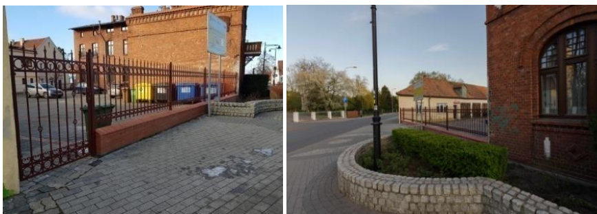
Przebudowa ogrodzenia przy budynku UM
