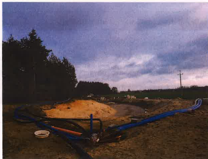
Budowa zbiornika retencyjnego
