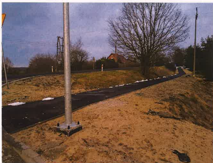
Ścieżka rowerowa wzdłuż drogi wojewódzkiej – II etap
