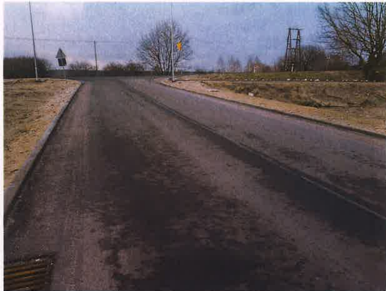
Nawierzchnia drogi gminnej nr 050859C wykonana w ramach budowy zbiornika
