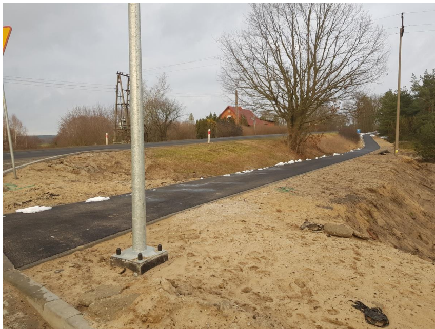
Ścieżka rowerowa wzdłuż drogi wojewódzkiej – II etap
