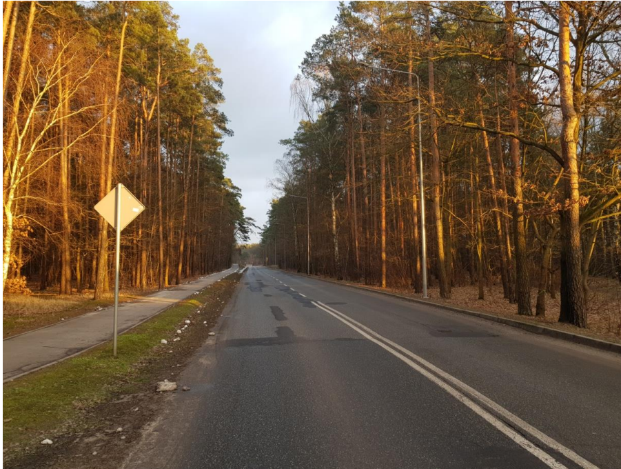
II etap - odcinek od ul. Orzechowej do ul. Powstańców
