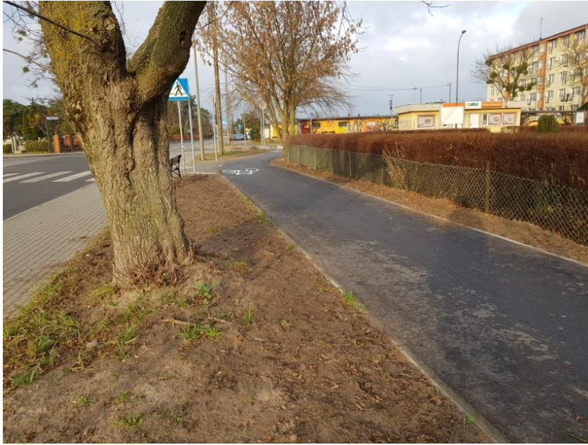
Ścieżka rowerowa wzdłuż ul. Długiej i ul. Ks. P. Skargi – I etap
