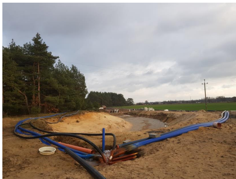
Budowa zbiornika retencyjnego
