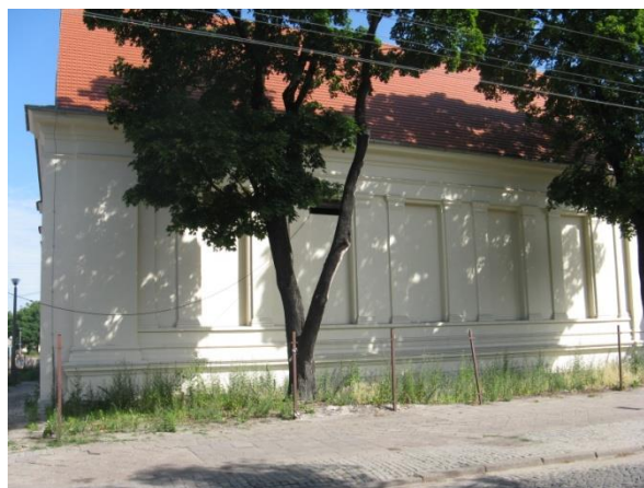
Fot. 41. Synagoga (fot. J. Korpala)
