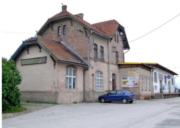
Fot. 195. Budynek dworca kolejowego (fot. P. Rutkowski)
