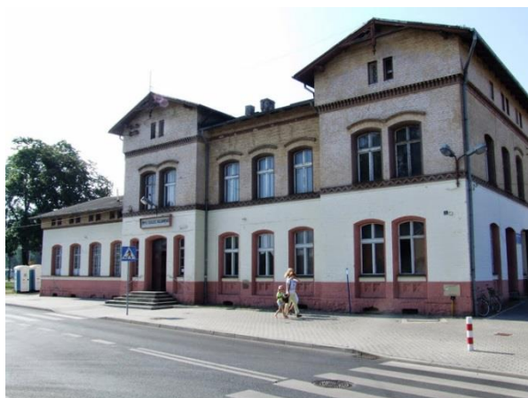
Fot. 181. Budynek dworca kolejowego (fot. P. Rutkowski)
