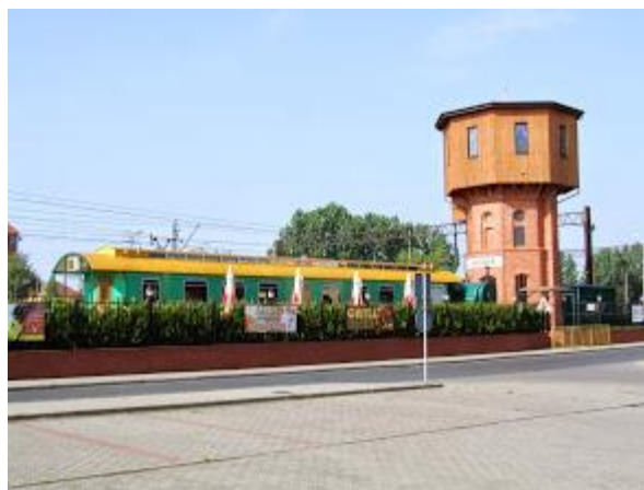
Fot. 182. Wieża ciśnień (fot. P. Rutkowski)
