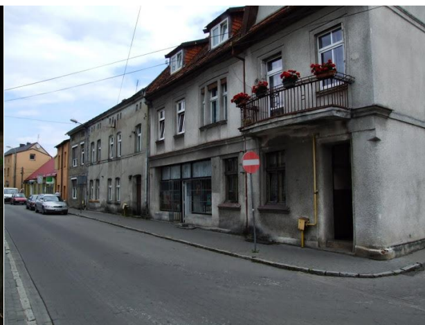
Fot. 191. Kamienice wymagające remontu (fot. P. Rutkowski)
