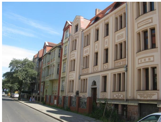
Fot. 56. Ulica I. Paderewskiego (fot. J. Korpala)
