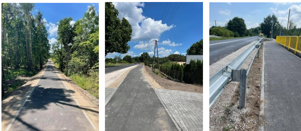
Ścieżka rowerowa łącząca Solec Kujawski z Otorowem i dalej z Łęgowem
