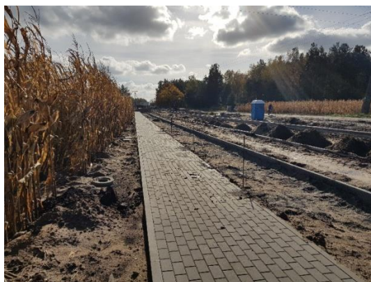
Budowa ul. Łąkowej
