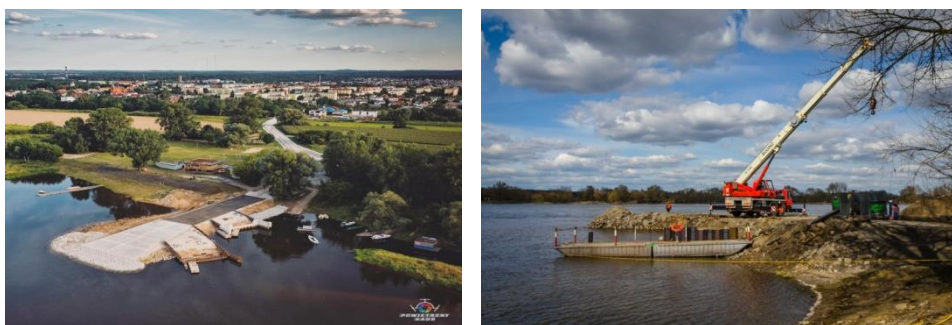
Budowa przyczółka dla promu
