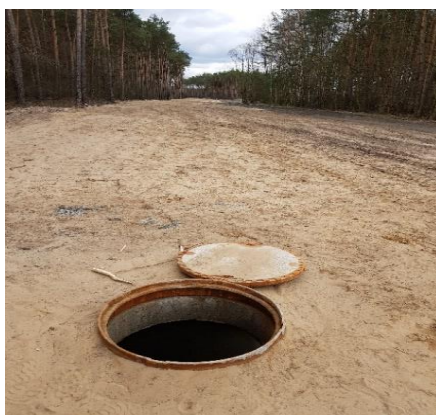
Wybudowana kanalizacja deszczowa
