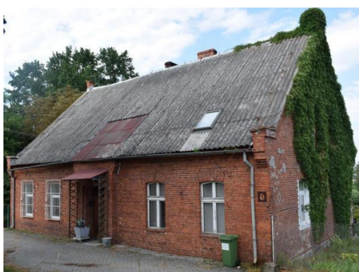
Świećlica wiejska w Przyłubiu przed remontem
