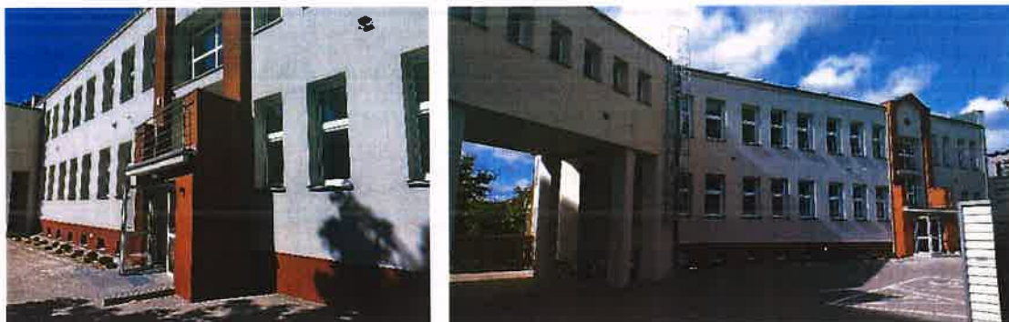
Termomodernizacja budynku przy ul. Kościuszki 12 (segment C)
