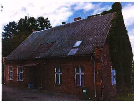
Świątelnia wiejska w Przyłubiu przed remontem
