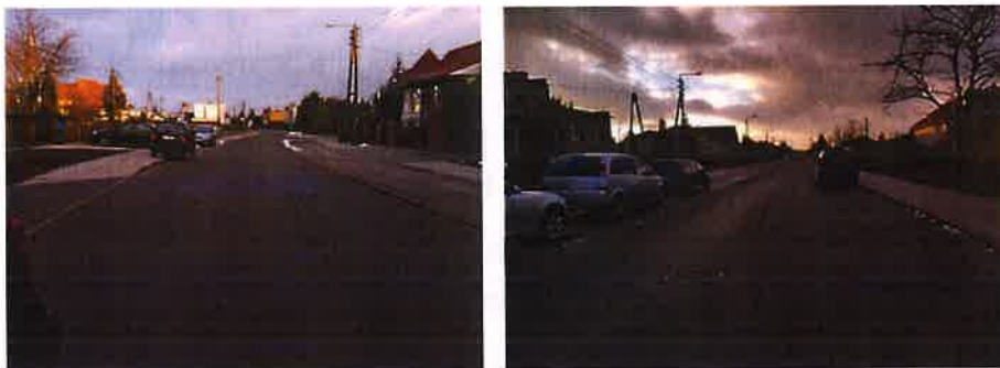
Przebudowana ul. Prosta
