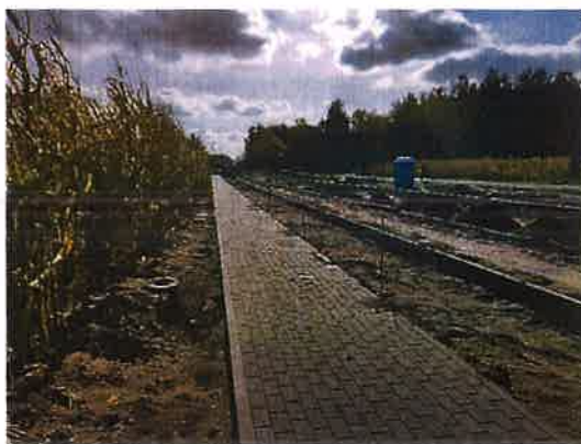
Budowa ul. Łąkowej
