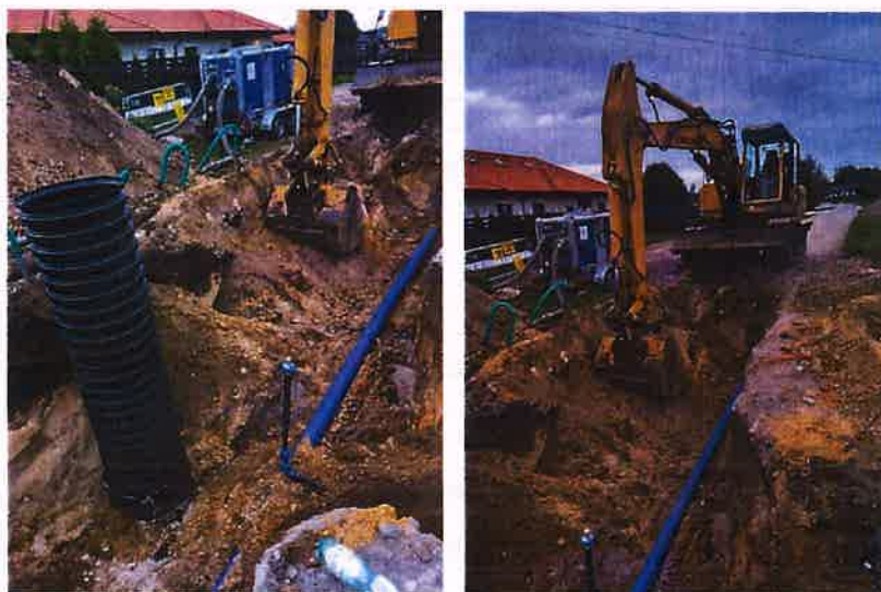
Budowa sieci kanalizacji sanitarnej w ul. Szarych Szeregów
