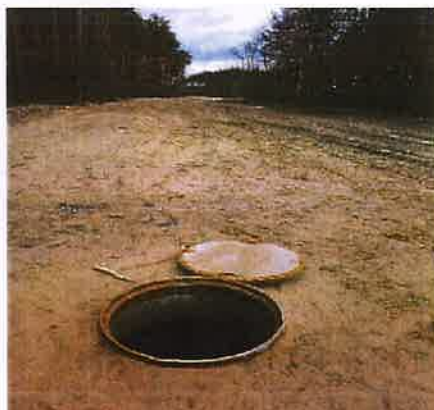
Wybudowana kanalizacja deszczowa
