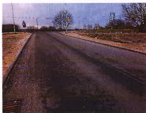
Odcinek drogi gminnej nr 050859C
