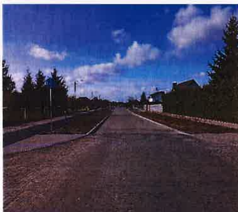
Ul. Zbożowo po przebudowie
