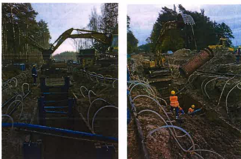
Budowa sieci kanalizacji deszczowej w ul. Targowej
