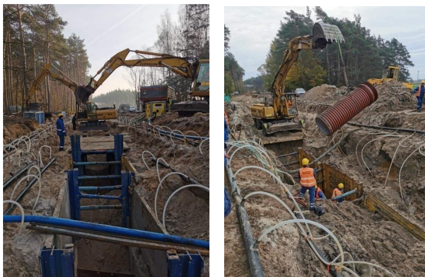
Budowa sieci kanalizacji deszczowej w ul. Targowej
