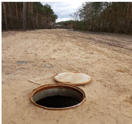
Wybudowana kanalizacja deszczowa
