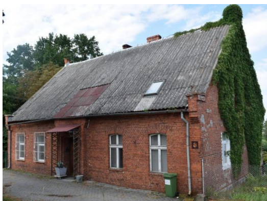
Świećlica wiejska w Przyłubiu przed remontem
