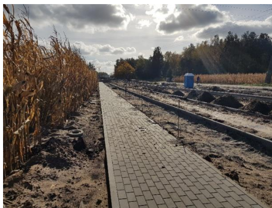
Budowa ul. Łąkowej
