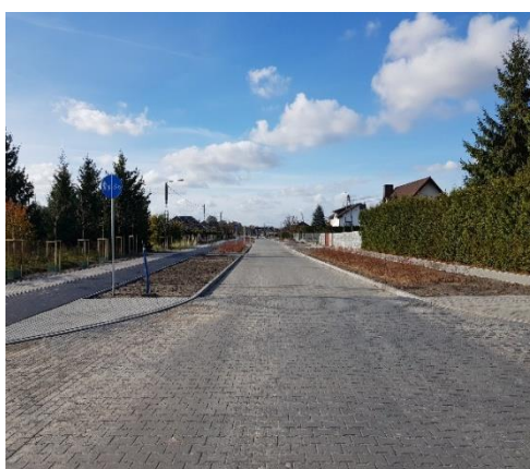
Ul. Zbożowo po przebudowie
