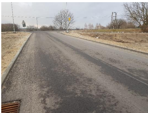
Odcinek drogi gminnej nr 050859C
