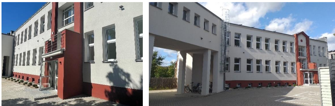
Termomodernizacja budynku przy ul. Kościuszki 12 (segment C)
