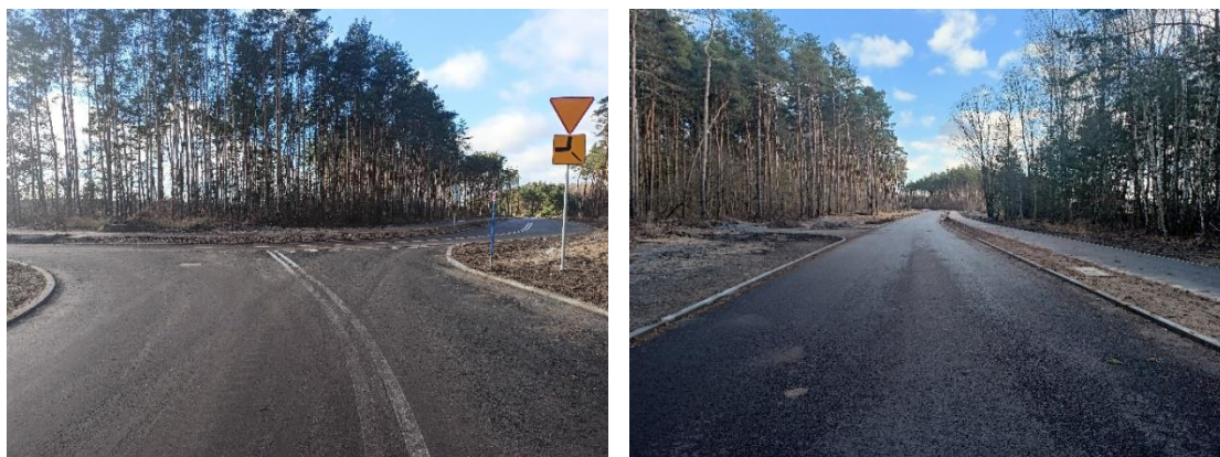
Wybudowany odcinek ul. Targowej
