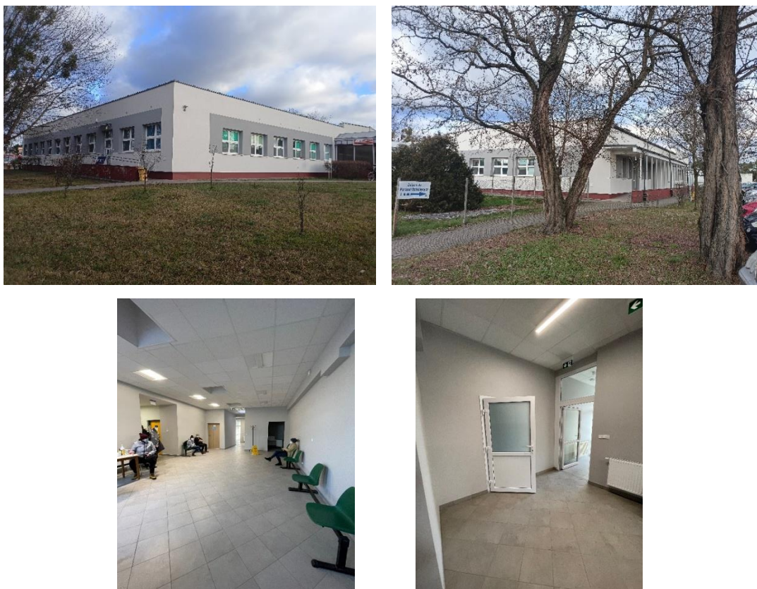
Termomodernizacja budynku Przychodni Zdrowia przy ul. Powstańców 7A
