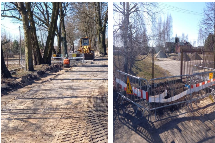
Budowa sieci wod. – kan. w ul. Wiejskiej
