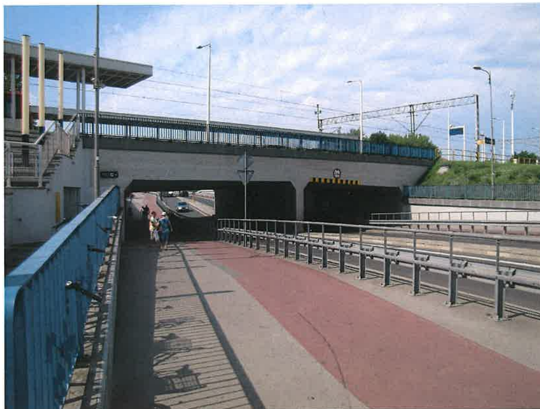
Fot. 4. - widok wiaduktu od strony północnej
