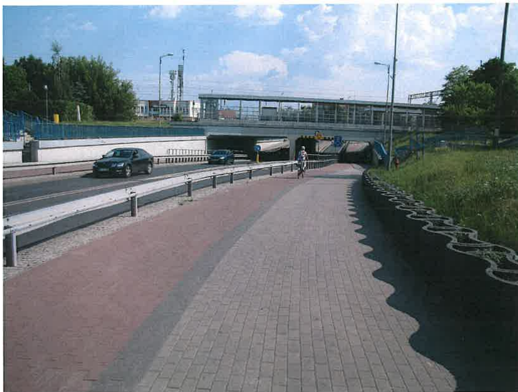
Fot. 3. – widok wiaduktu od strony południowej
