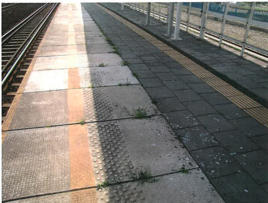
Fot. 11 – porost roślinności na nawierzchni peronu
