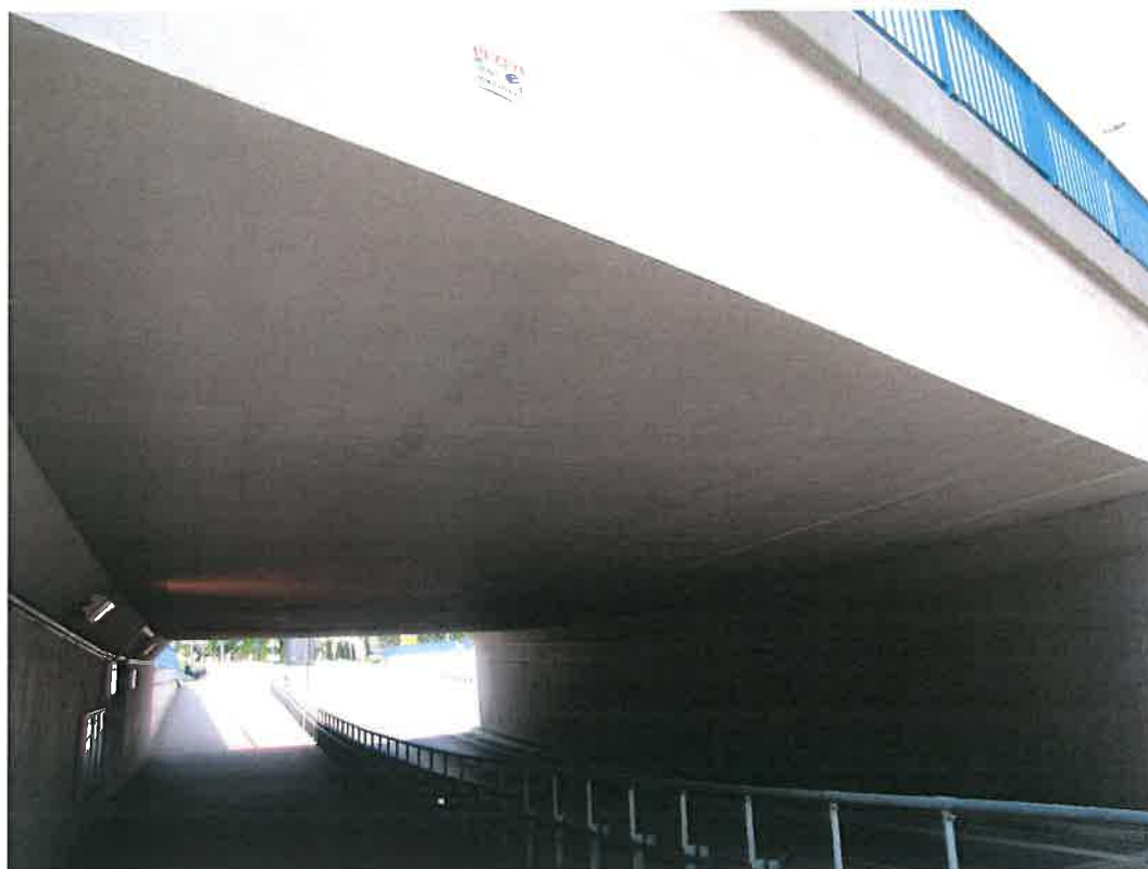
Fot. 5. – spód przęsła wschodniego
