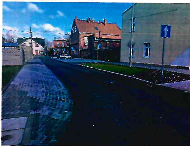
Przebudowana ul. Ułańska z nowymi miejscami parkingowymi.
