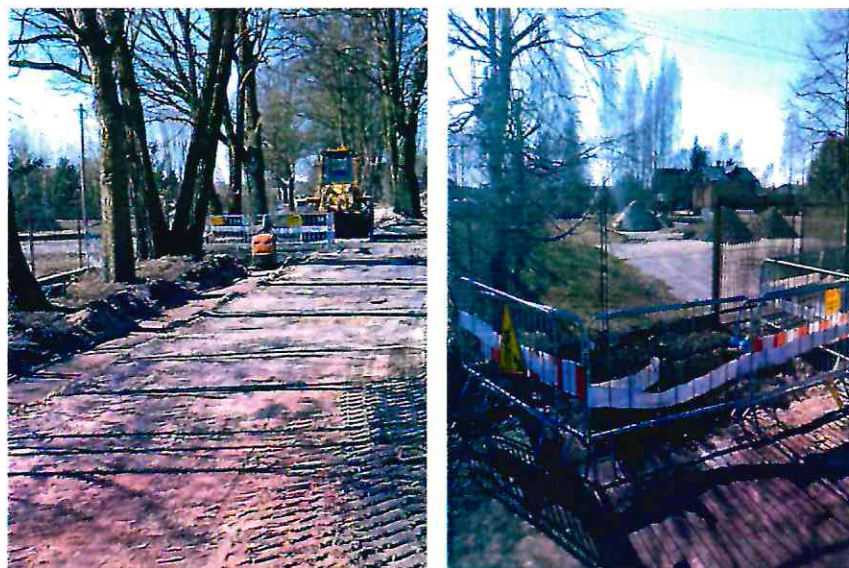
Budowa sieci wod. – kan. w ul. Wiejskiej
