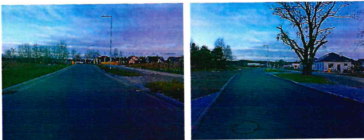
Budowa odcinków dróg na Osiedlu Leśnym
